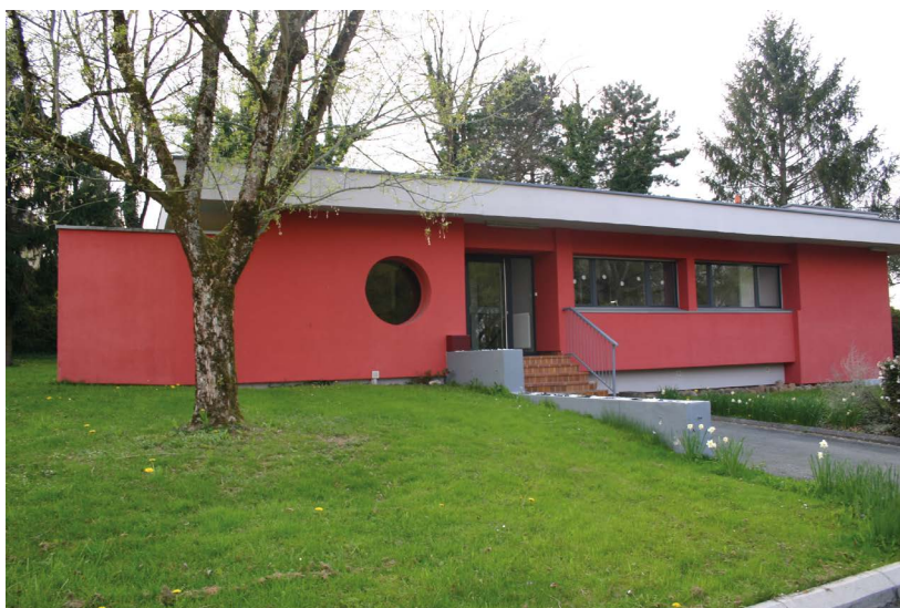
Le siège social rénové de l'ASEA Nord Franche-Comté à Grange la Dame
